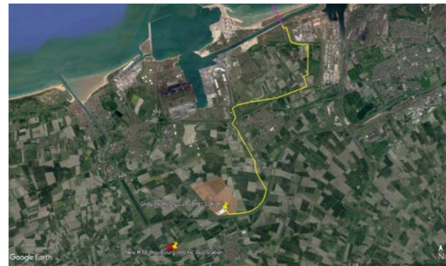
Route du câble terrestre de Dunkerque et site de la station de conversion
