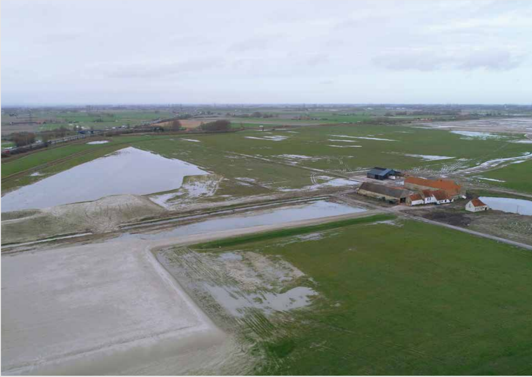
Photo aérienne du site de la station de conversion à Bourbourg
